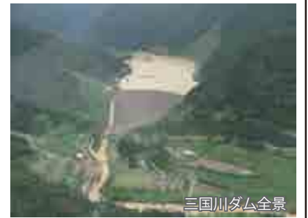
信濃川水系三国川の三国川ダムでは最大約 1,800 万 m 3 の洪水を貯留。また、ダム地点への最大流入量約 640m 3 /s を約 562m 3 /s 調節し、下流の水位低下に寄与。
