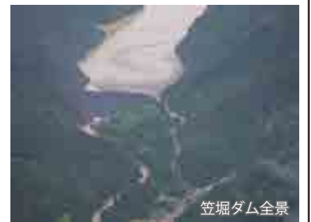
信濃川水系五十嵐川の笠堀ダムでは、最大約 858 万 m 3 の洪水を貯留。またダム地点への最大流入量約 1,005m 3 /s を約 822m 3 /s 調節し、下流の氾濫量の軽減に寄与。
