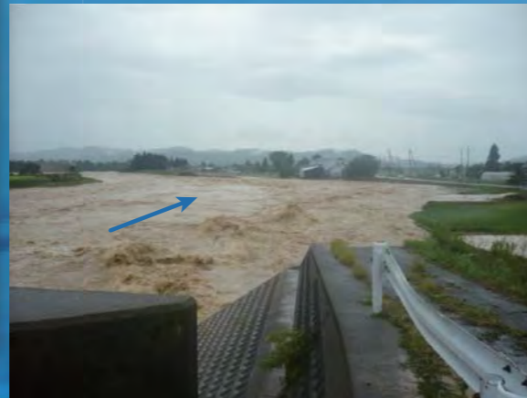
五十嵐川における堤防決壊（三条市江口）
