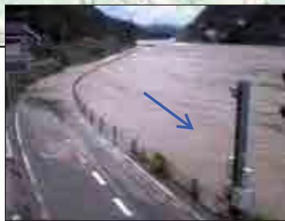
24 阿賀野川国道 49 号路面冠水 （東蒲原郡阿賀町大牧）
