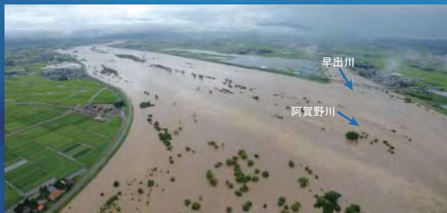
阿賀野川を流れる濁流（阿賀野市・五泉市）
